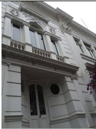
Figura 115. Vista lateral de la Palacete Sousa (II)
