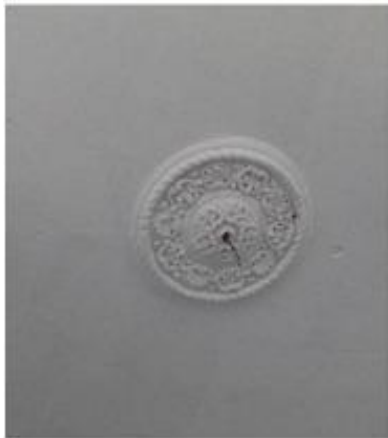
Figura 117. Deterioro instalaciones eléctricas del Palacete Sousa
