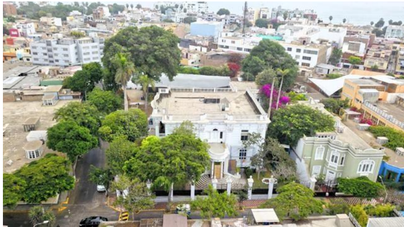
Figura105. Vista aérea de Palacete Sousa
