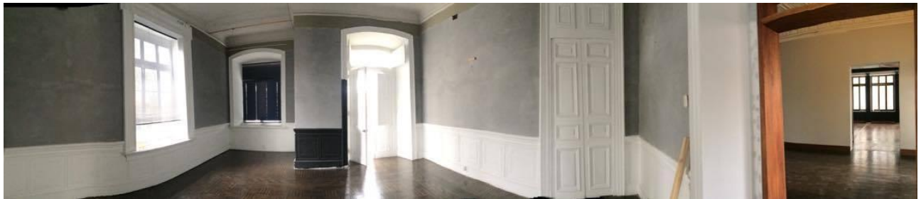
Figura106. Vista interior del primer piso de Palacete Sousa (I)
