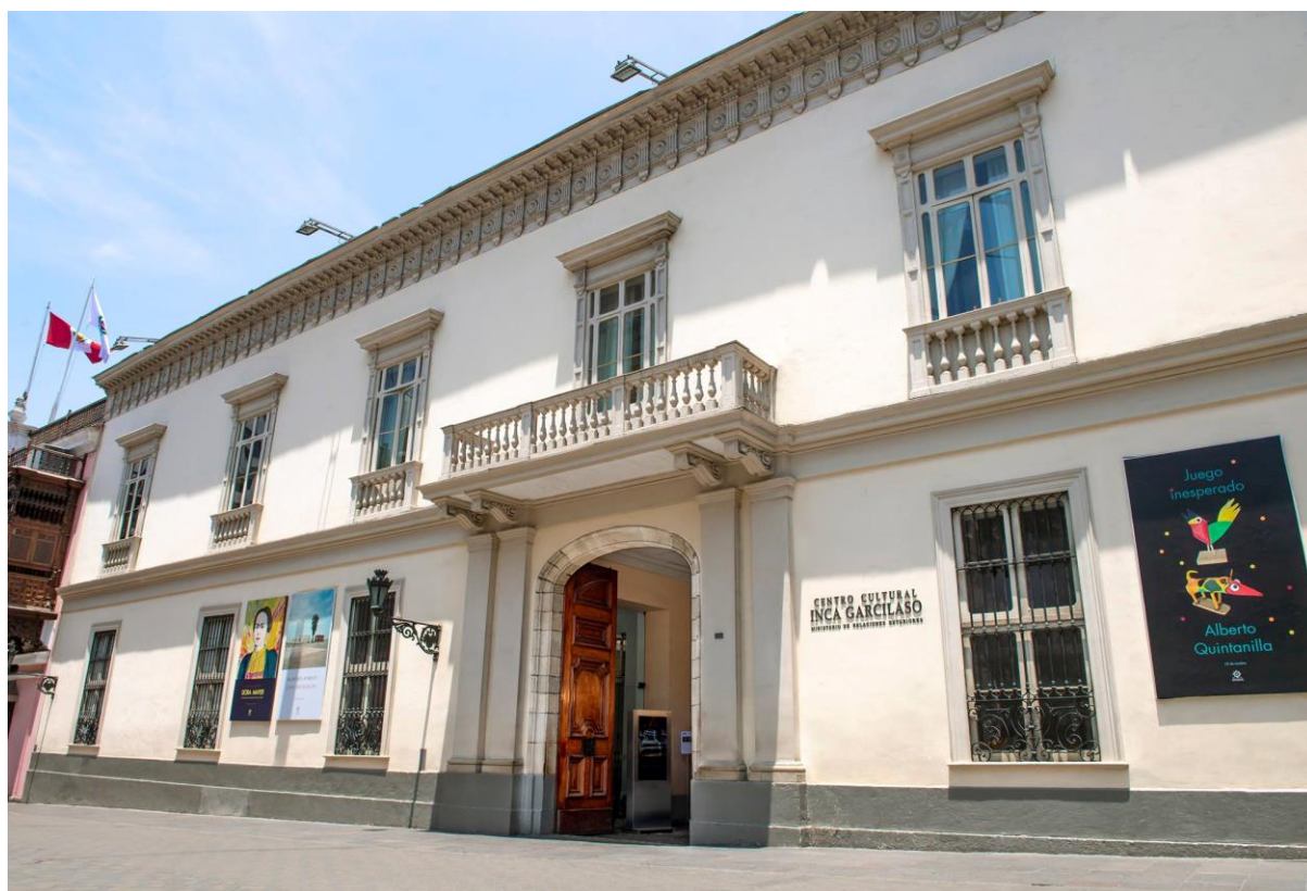
Figura 39. Fachada Centro cultural Inca Garcilaso. Fuente: Web PERÚ, Lima
