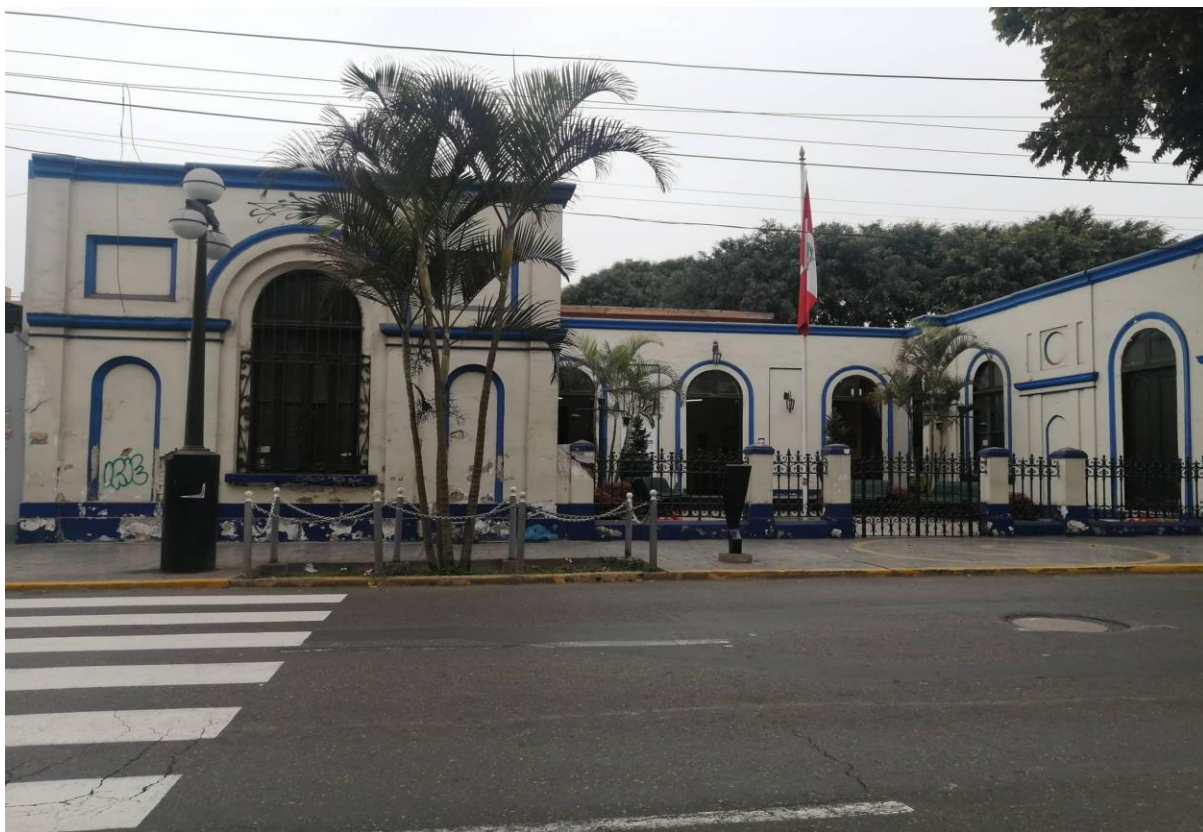
Figura 23. Fachada 1. Fuente: Merino, M.
