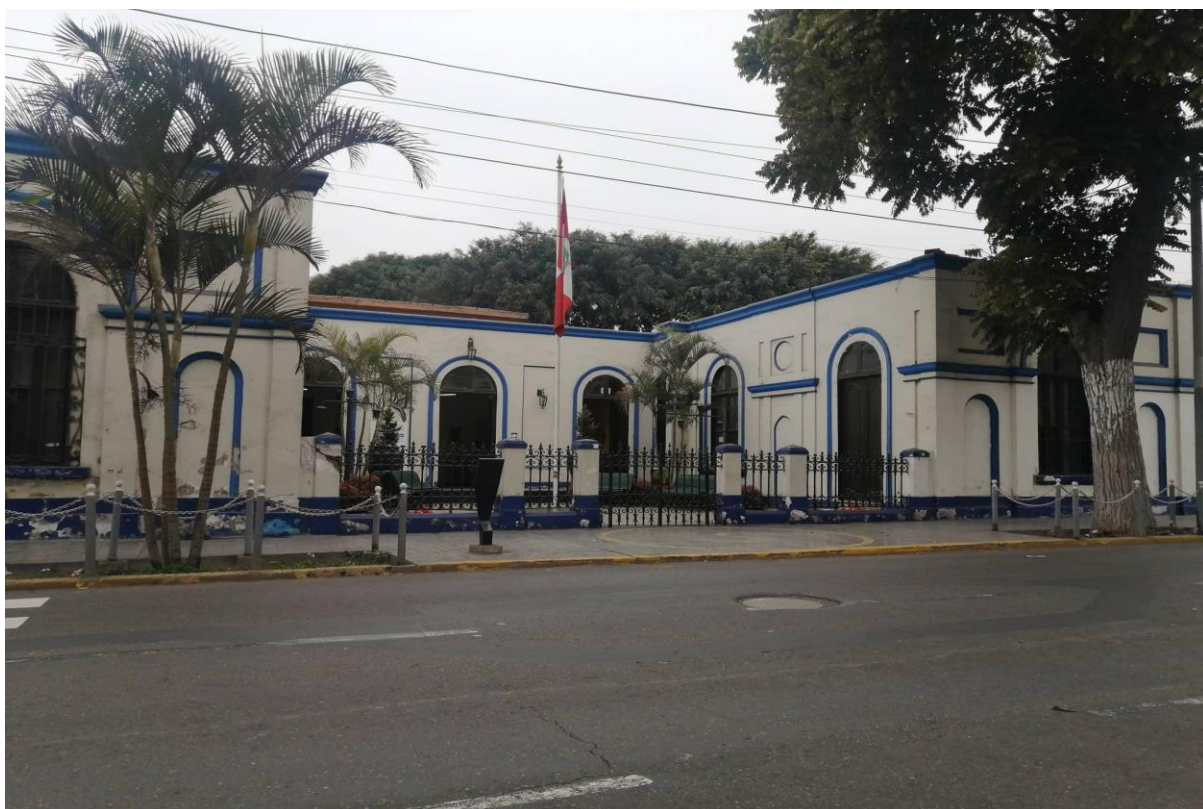
Figura 24. Fachada 2. Fuente: Merino, M.
